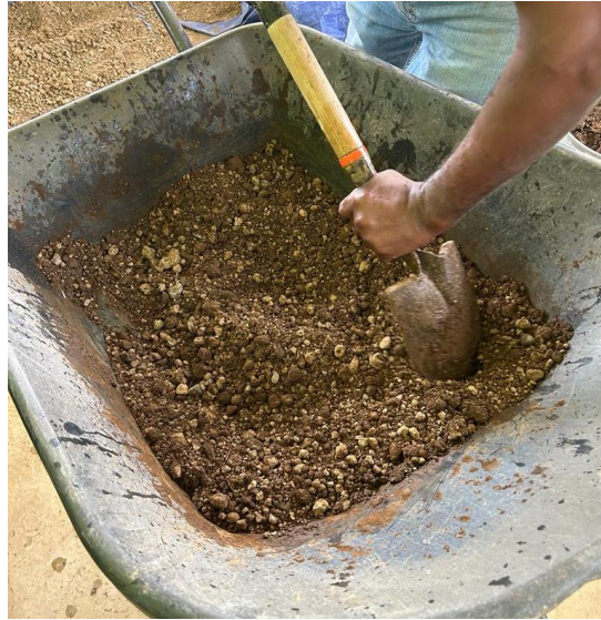
Figura 47. Consistencia del material para el proceso de llenado y compactación.
