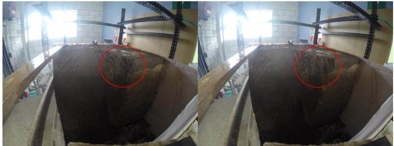
Figura 77. Primer desprendimiento de material observado en el talud de pendiente 90°.
