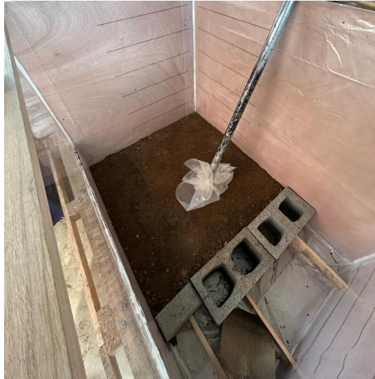
Figura 52. Capas de 15 cm y sistema de contención para el proceso de llenado y compactación.
