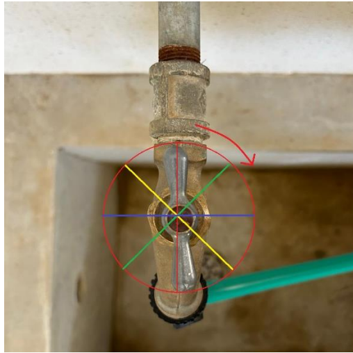
Figura 57. Apertura de la llave del tubo a 45°, 90° y 135°.
