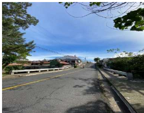
Figura 143. Vista panorámica del puente San Cayetano – Iglesia.
