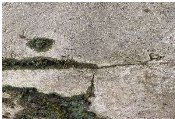
Figura 140. Moho en grietas del cuerpo principal del bastión.
