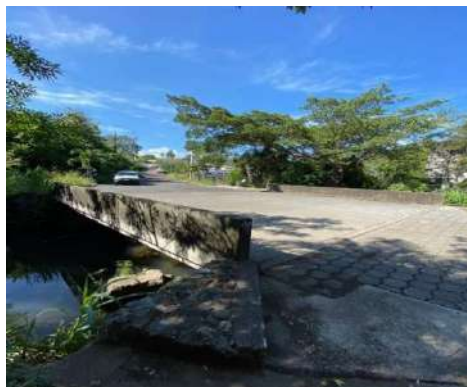
Figura 88. Vista panorámica del puente Cementerio Metropolitano.
