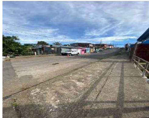
Figura 67. Vista panorámica del puente Barrio La Cruz.
