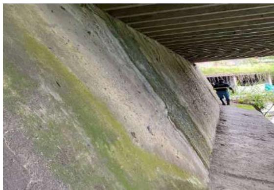
Figura 132. Moho, agua filtrada y eflorescencia en cuerpo principal del bastión.
