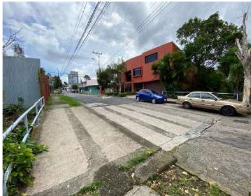
Figura 108. Vista panorámica del puente Lomas de Ocloro.
