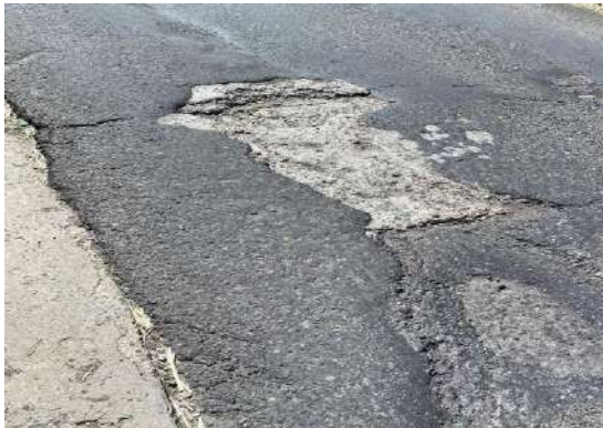
Figura 105. Baches en la superficie de rodamiento.
