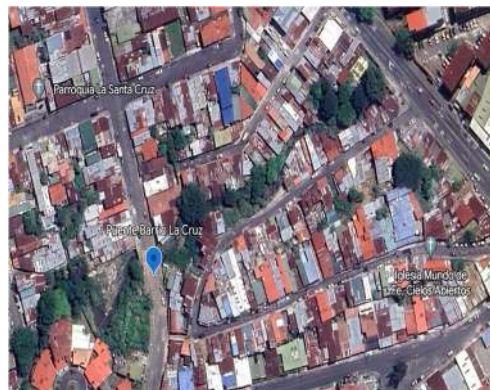
Figura 68. Fotografía satelital del puente Barrio La Cruz.
