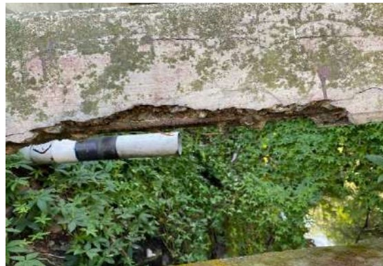
Figura 154. Acero de refuerzo expuesto y reducción en la sección en barandas de concreto.
