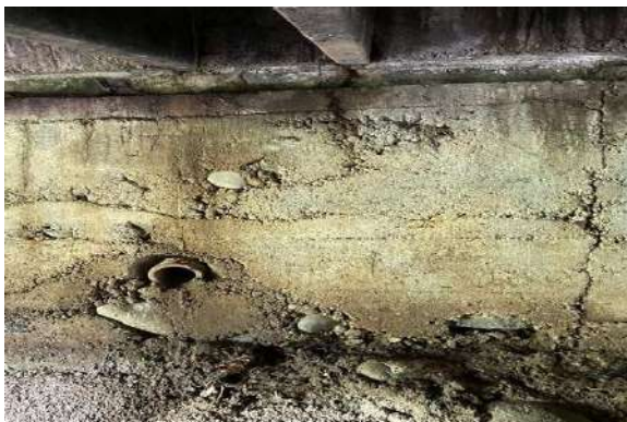
Figura 112. Nidos de piedra y agrietamiento en cuerpo principal del bastión.
