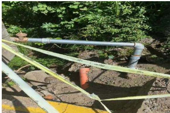
Figura 159. Deslizamiento en extremo del puente.
