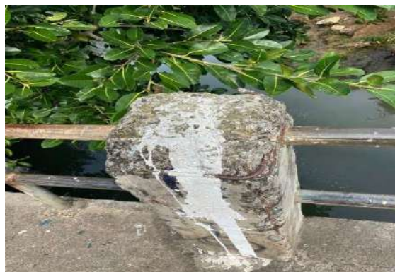
Figura 70. Baranda de concreto con acero de refuerzo expuesto y reducción de la sección.
