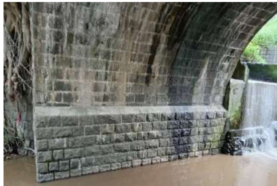
Figura 119. Arco de paso superior con filtración de agua y eflorescencia.
