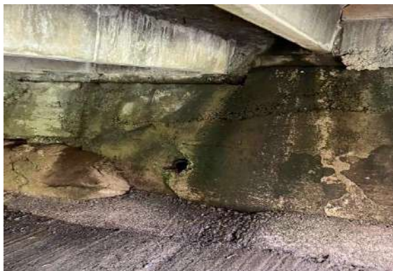
Figura 112. Nidos de piedra y agrietamiento en cuerpo principal del bastión.
