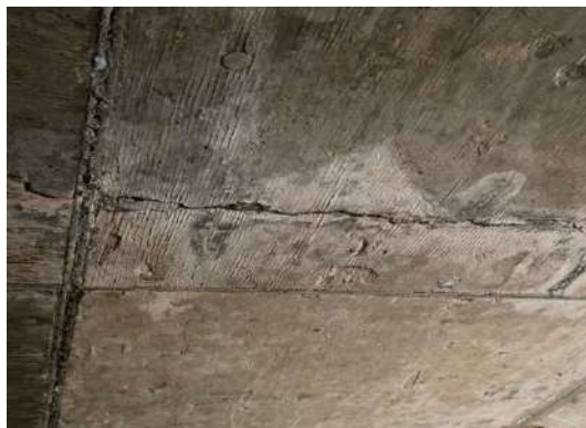
Figura 92. Viga cabezal del bastión con acero de refuerzo expuesto y paso de tubería en mal estado.
