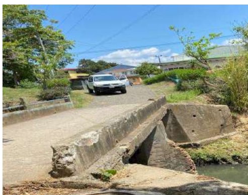
Figura 122. Vista panorámica del puente Parque de La Paz.
