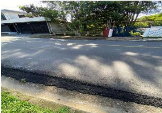
Figura 152. Sobre capas de asfalto en superficie de rodamiento.
