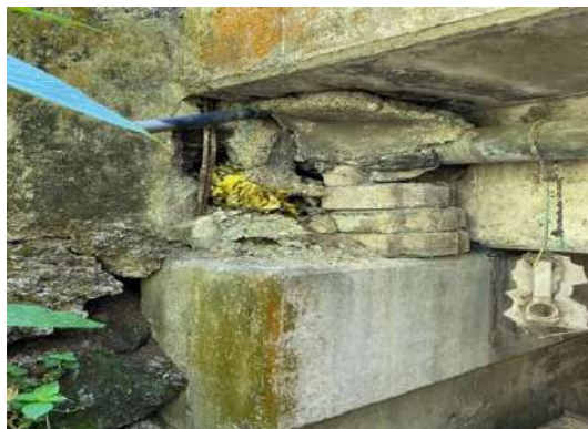
Figura 92. Viga cabezal del bastión con acero de refuerzo expuesto y paso de tubería en mal estado.
