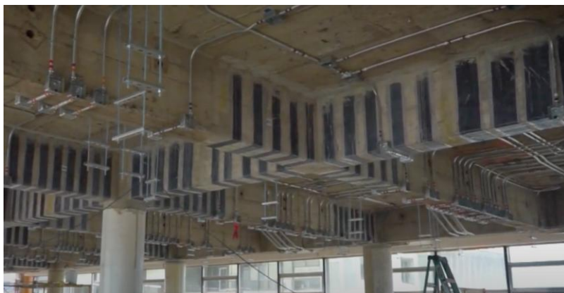
Figura 18. Fibra de carbono en Vigas
