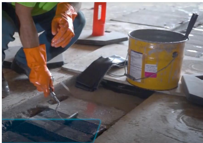
Figura 19. Aplicación de fibras de carbono en vigas
