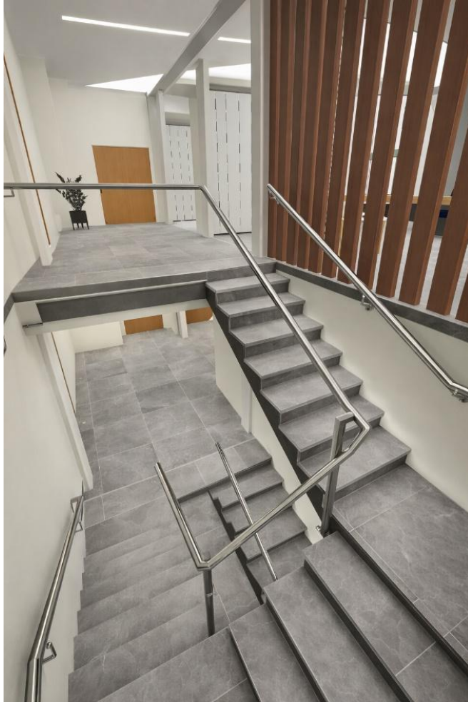
Figura 110. Vista del núcleo de escaleras
