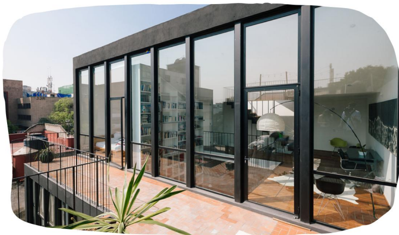
Figura 7. Uso de ventanales de vidrio y marcos de acero
