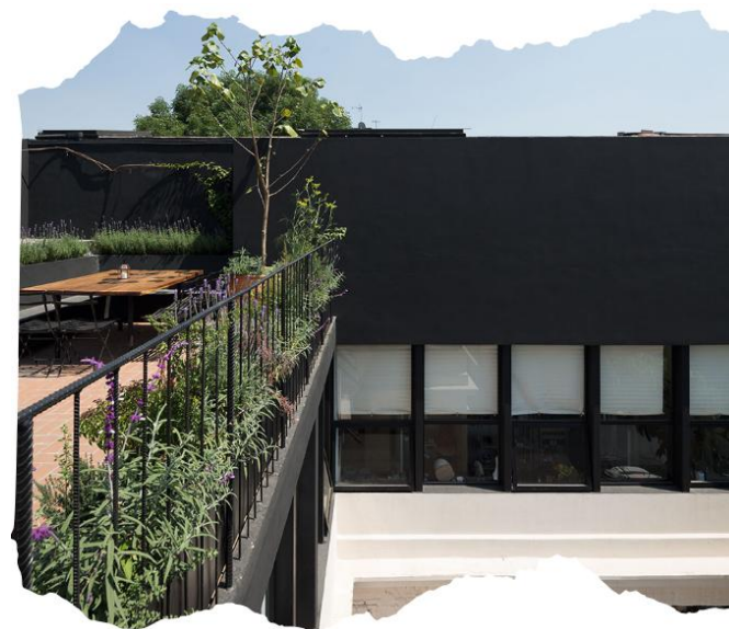
Figura 8. Azotea del edificio
