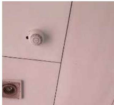
Imagen 24. Luminarias habitaciones. Fuente: Elaboración propia, (2023).
