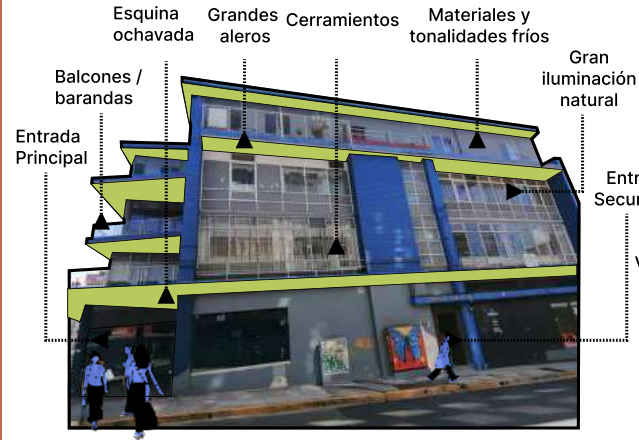
Imagen 69. Fotografías del costado Oeste del edificio Trejos González con diagramas exploratorios. Fuente: Elaboración propia. (2023).
