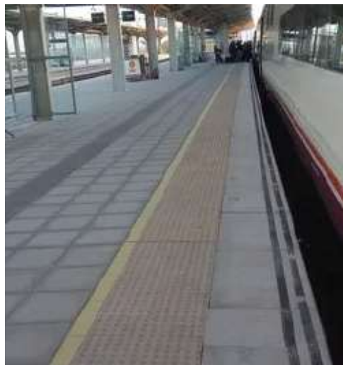
Figura 3. Banda podotáctil en el borde del andén.
