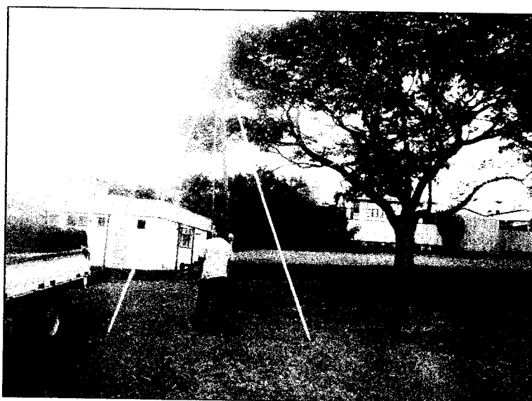
Fotografía 1. Vista de perforación P-1.
