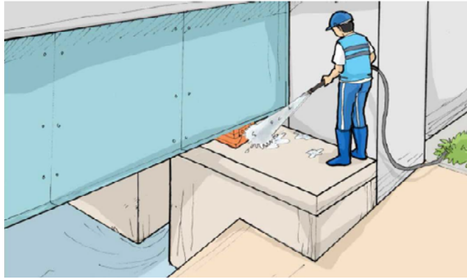
Figura 66. Limpieza de los apoyos.
