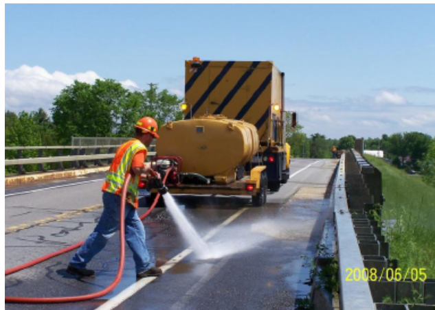
Figura 64. Lavado con agua a presión.
