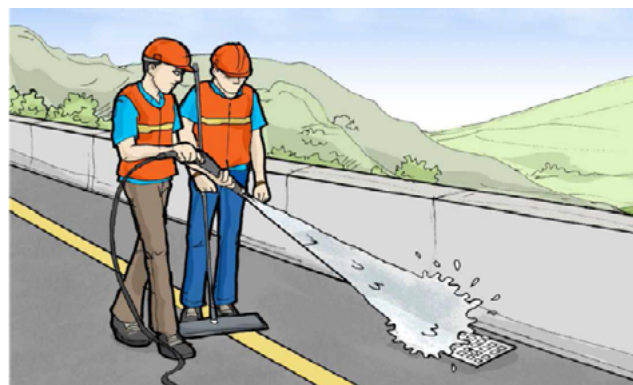
Figura 65. Limpieza de los drenajes.
