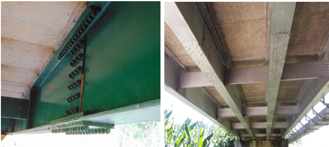
Figura 111. Recuperación de la pintura en elementos de acero. Fuente: PEEP (2018).
