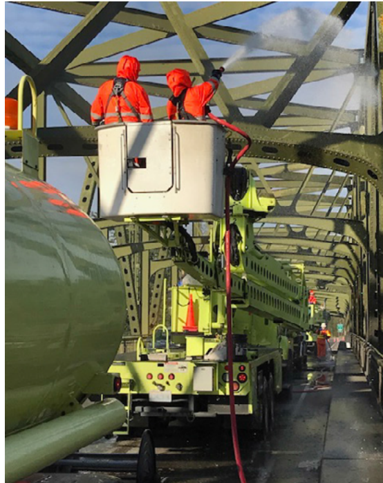
Figura 73. Limpieza de la superficie de acero con agua a presión. Fuente: Federal Highway Administration (2018).
