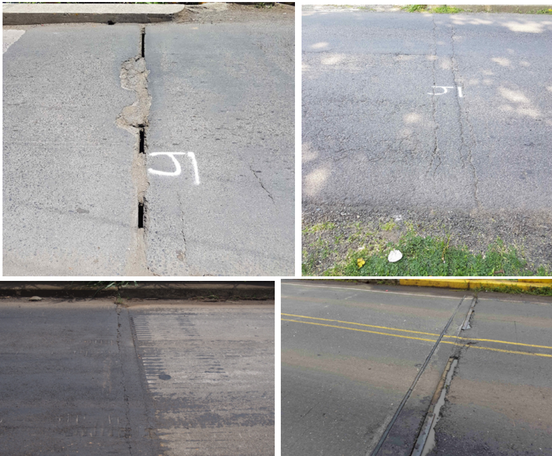
Figura 62. Juntas obstruidas.
