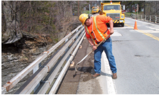
Figura 63. Limpieza manual del puente.
