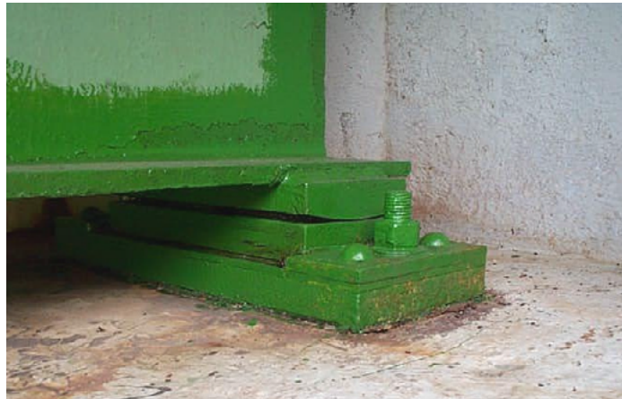
Figura 118. Apoyo reemplazado o sustituido.
