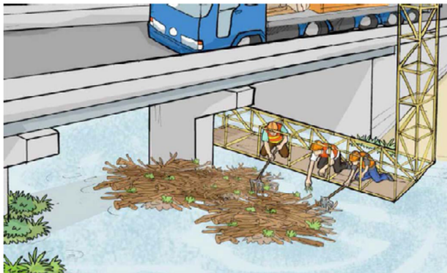
Figura 68. Remoción de ramas de las pilas.
