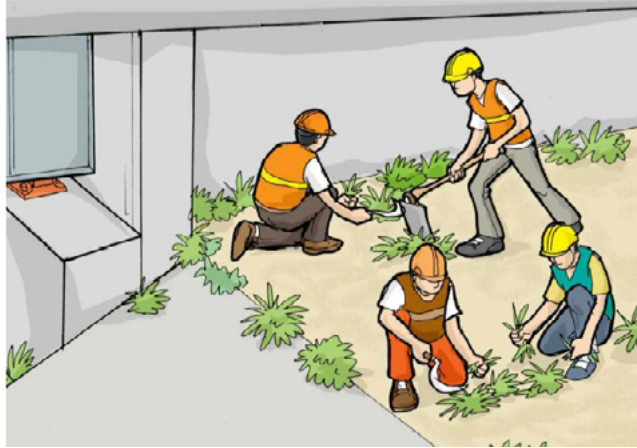
Figura 69. Remoción de la vegetación del derecho de vía. Fuente: JICA (2014).
