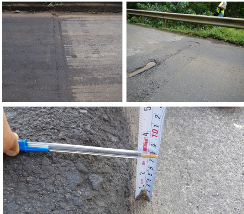
Figura 90. Sobrecapas de pavimento.
