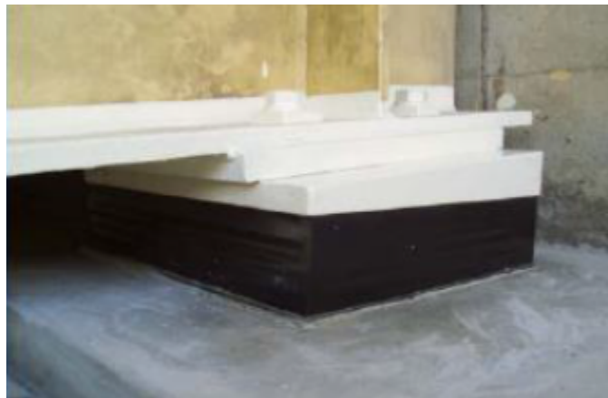
Figura 119. Apoyo reemplazado o sustituido.
