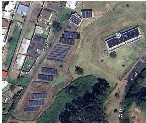
Figura 5.1: Vista en Google Maps del parque solar, Cartago
