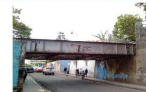
1D Puente Entrada Oeste Estacion al Atlantico
