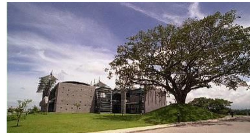
Imagen 66 Captación de Lluvias Holcim
