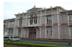
5I Escuela Metálica - Buenaventura Corrales
