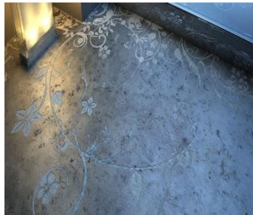
Imagen 22 Pisos de Concreto Lujado
