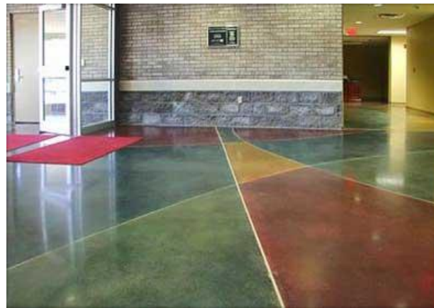
Imagen 23 Pisos de Concreto Lujado
