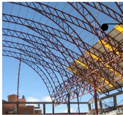
Vigas Curva Americana en Acero
