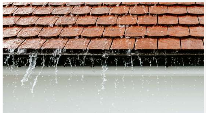
Imagen 169, 170, 171 y 172 - Elementos Electromecánicos: Parasoles, Luz LED, Calentador Solar, Caída Pluvial Libre. (De arriba hacia abajo)
