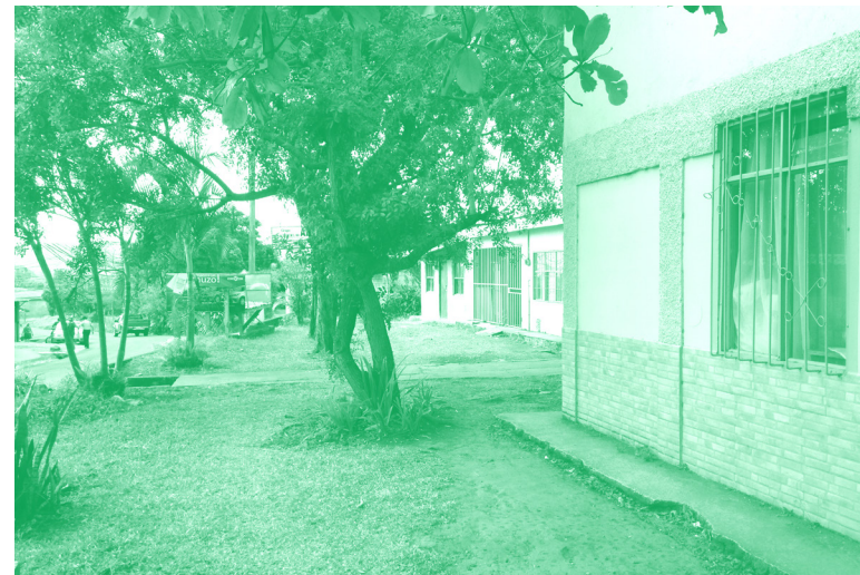
Fachada Sur/ Acceso a jardín frontal
