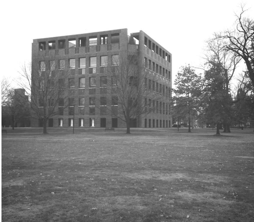
Volumen de geometría simplificada que se planta excento en el terreno aumentando su percepción como cuerpo unitario.
