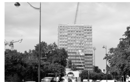
Proceso de construcción
