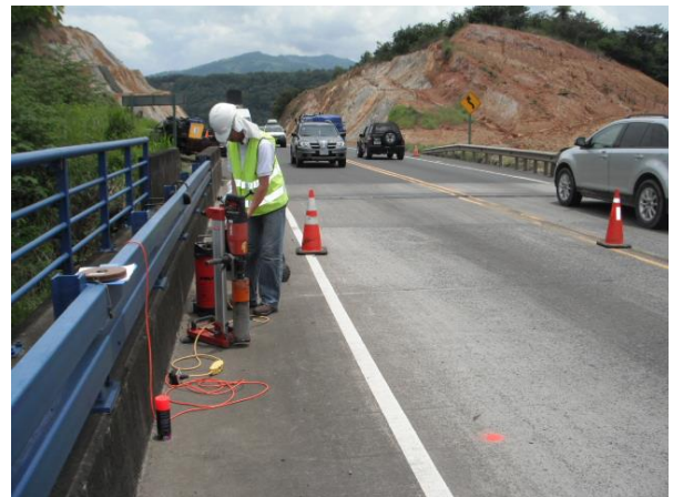
Figura 11. Demarcación de zona de trabajo
