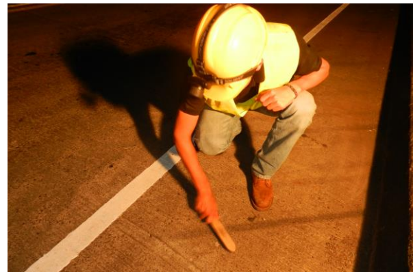
Figura 16. Preparación de la zona de trabajo
