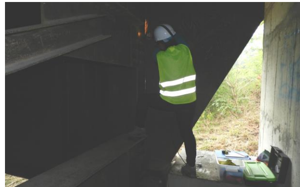
Figura 26. Limpieza de soldaduras.
