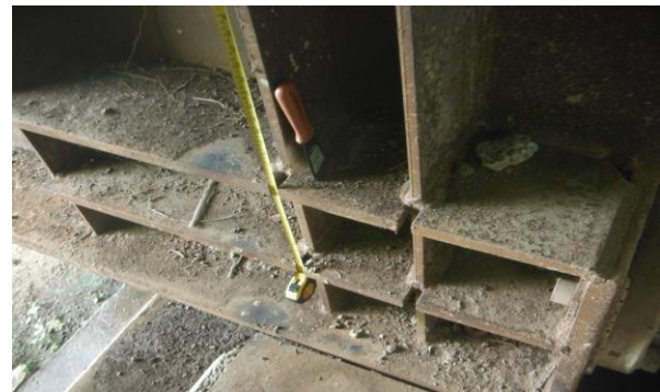
Figura 18. Longitud de atiesadores.
