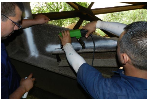
Figura 28. Ejecución de ensayo (magnetización y aplicación de partículas)
