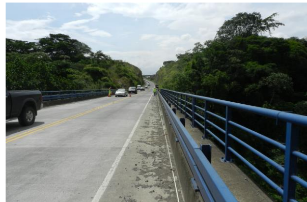
Figura 1. Paso regulado en el puente sobre el río Ciruelas
