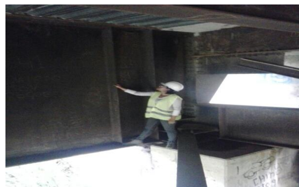
Figura 20. Peralte de vigas principales
