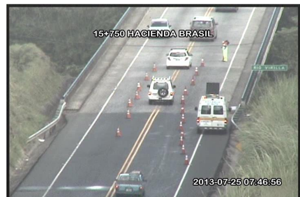
Figura 2. Estrechamiento de carril en el puente sobre el río Virilla
