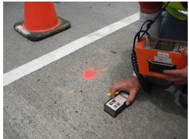
Figura 12. Ubicación de acero de refuerzo
