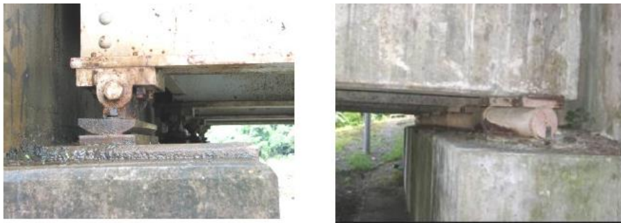
Figura 10. Apoyo tipo patín y apoyo tipo rodillo Fuente: MOPT (2007)
