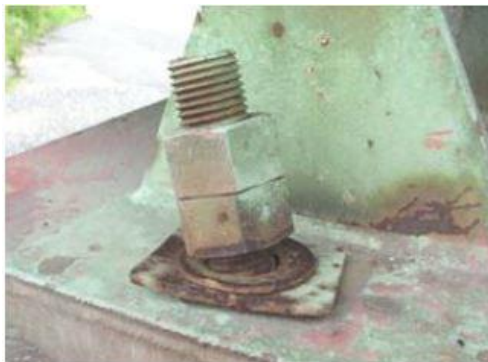
Figura 34. Deformación del perno
