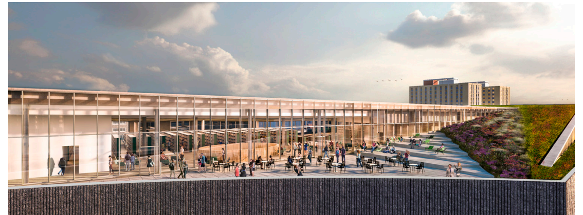
Imagen 34. Vista de terraza en cubierta
