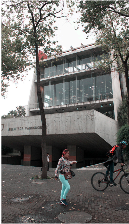
Imagen 38. Vista exterior de la biblioteca
