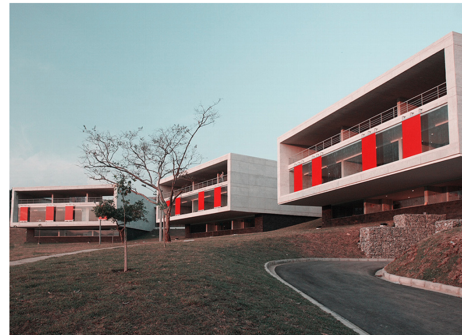
Imagen 65. Vista exterior de la biblioteca
