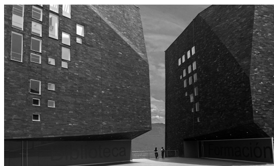
Imagen 67. Vista exterior de la biblioteca
