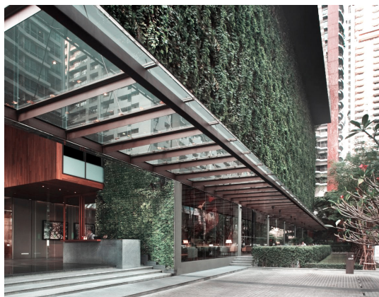
Imágenes 111 y 112. Uso de vegetación en muros
