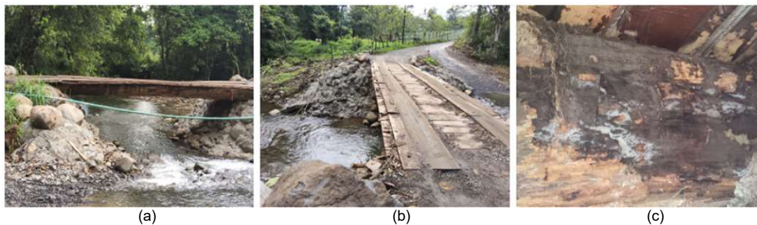
Figura 27. a) Vista general de puente n.º 6, b) Daño 1 y c) Daño 2
