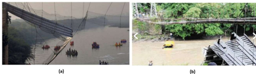
Figura 1. a) Fotografías de la caída del puente Gujarat y el b) puente sobre el río Tárcoles
