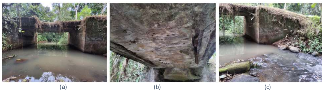
Figura 39. a) Vista general de puente n.º 18, b) Daño 1 y c) Daño 2
