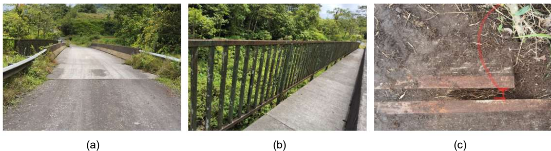
Figura 24. a) Vista general de puente n.º 3, b) Daño 1 y c) Daño 2
