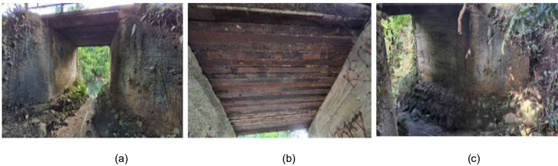
Figura 40. a) Vista general de puente n.º 19, b) Daño 1 y c) Daño 2
