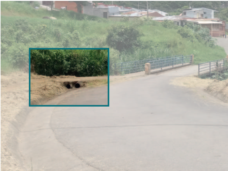
Imagen 68: Drenaje pluvial Fuente: Propia
