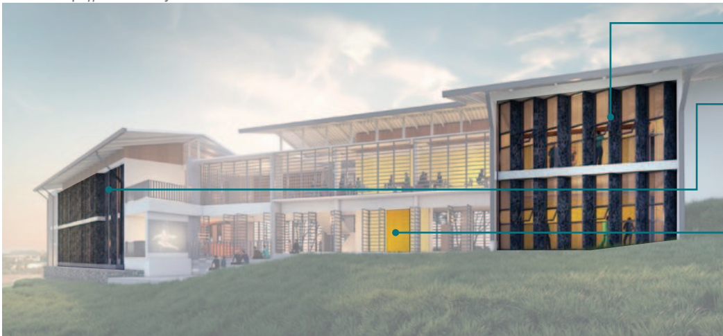
Imagen 135: Fachada Norte Centro de Formación Humana Fuente: https://scontent.fsjo3-1.fna.fbcdn.net
