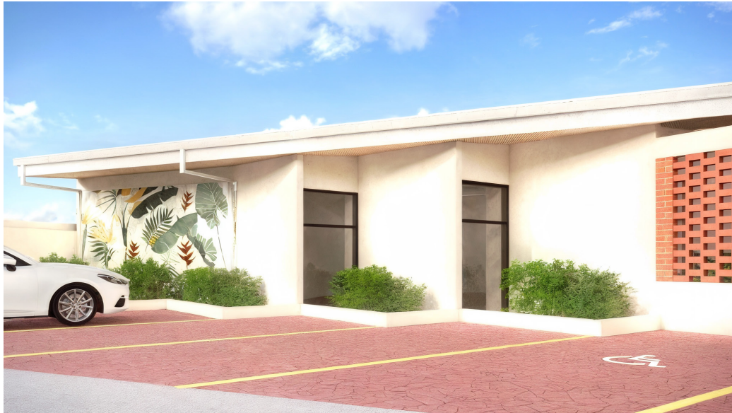
Figura 4.43: Fachada este, volumetría administrativa. Fuente: Elaboración propia
