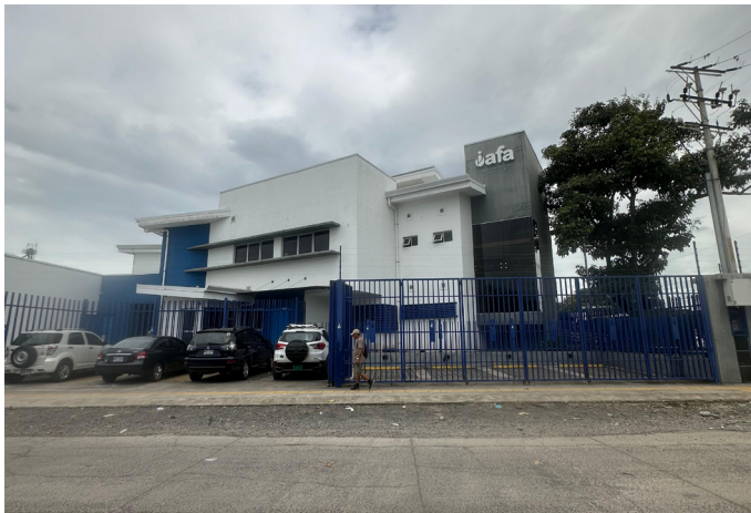
Figura 2.14: Fotografía de fachada este de Sede Regional Pacífico Central del IAFA. Fuente: Elaboración propia, visita de campo, 19 de diciembre, 2024.
