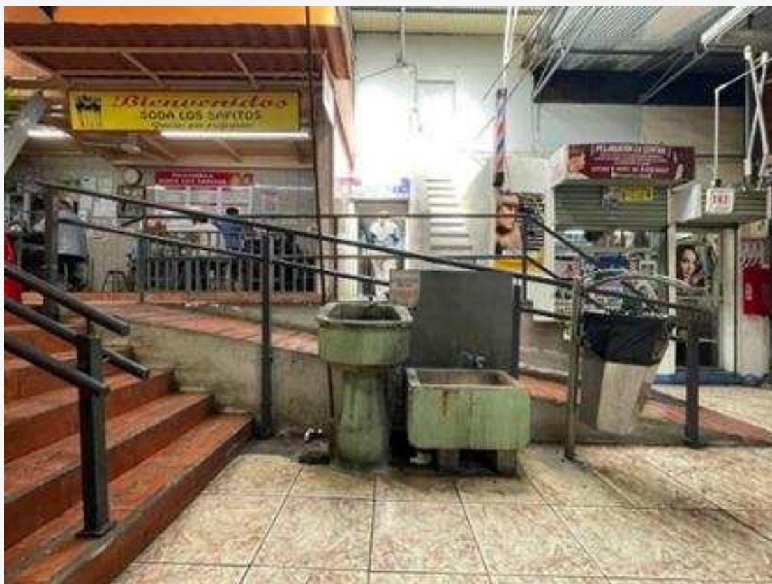
Figura 5. Fotografía de rampa frente a servicios sanitarios del Mercado de Alajuela. Nota. Elaboración propia.
