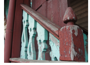
Detalle de barandilla y pasamanos
