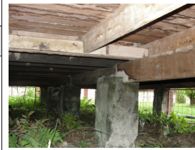
Detalle de pilotes
