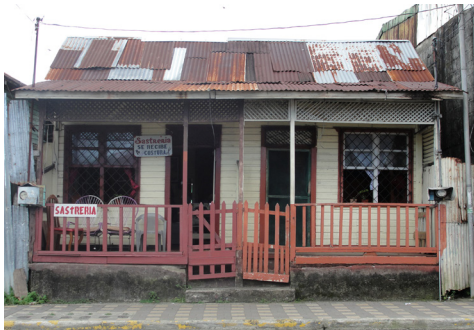
Descripción: Vista de fachada principal
