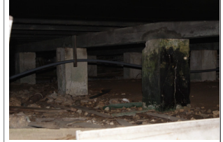
Pilotes y entrepiso
