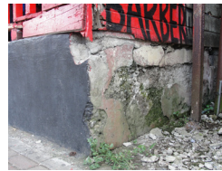
Detalle de zócalo
