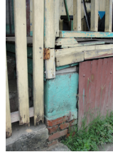
Remates con madera en entrepiso
