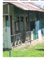
Vista lateral de fachada principal
