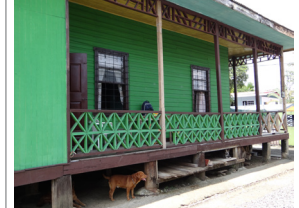
Detalle de baranda
