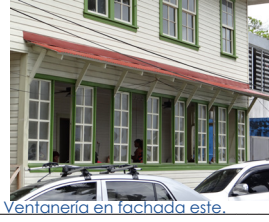
Ventanería en fachada este.
