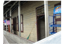
Detalle del corredor lateral
