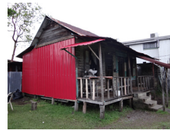
Estado actual de la vivienda
