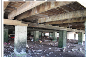
Detalle de pilotes y entripiso
