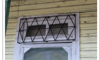
Detalle de reja metálica
