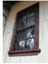
Detalle de ventana
