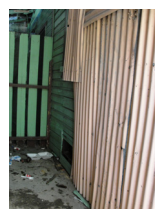
Corredor de la edificación
