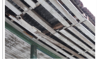
Detalle del cielo del alero
