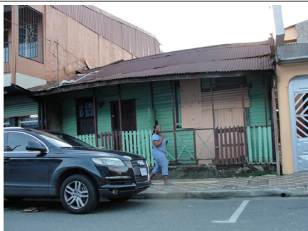
Descripción: Vista de fachada principal
