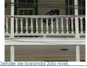
Detalle de baranda 2do nivel.
