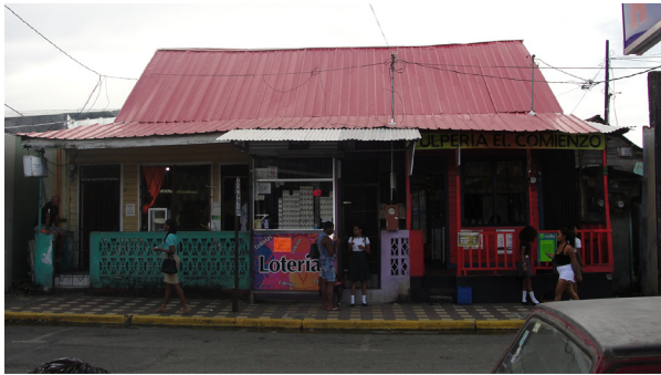
Descripción: Vista de fachada principal
