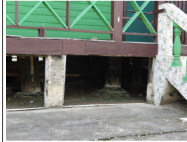
Detalle de pilotes
