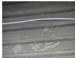
Tablillas machihembradas como cerramiento
