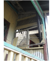
Estructura de cubierta y barandilla
