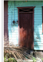
Detalle aleros y fachadas
