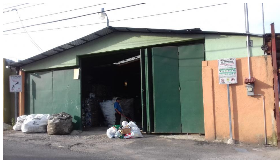
Figura 4.1. Instalación sin malla perimetral y con una única entrada para residuos y materiales.
