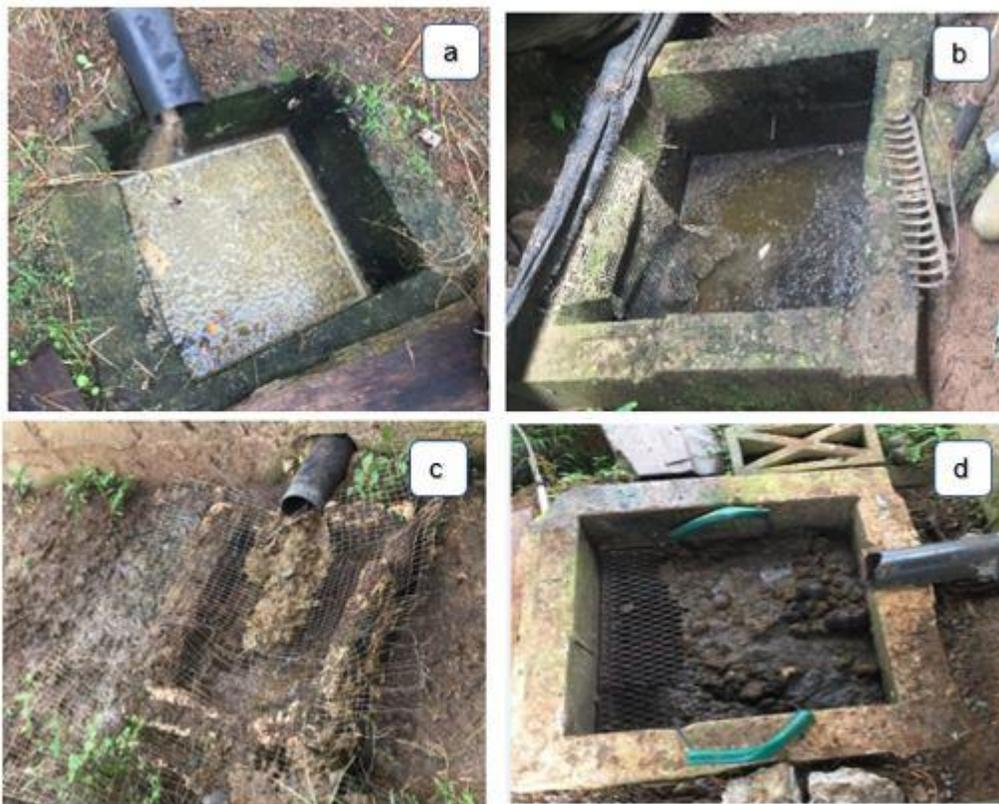
Figura 5-7. Diferentes escenarios de la presencia de rejillas a la salida de las porquerizas.
