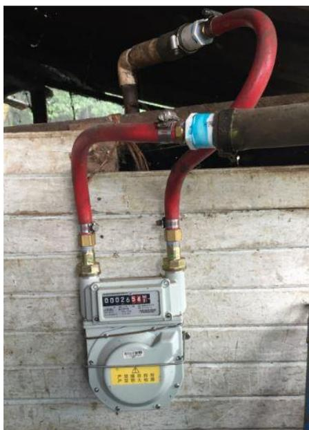
Figura 4-4. Flujómetro instalado en la cocina de Rafael Arias.
