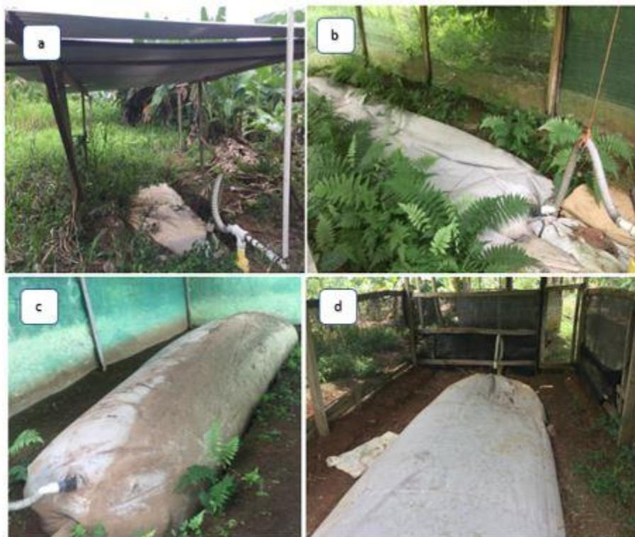
Figura 5-16. Biodigestores clasificados como muy malo (a), regular (b), muy bueno (c) y bueno (d).
