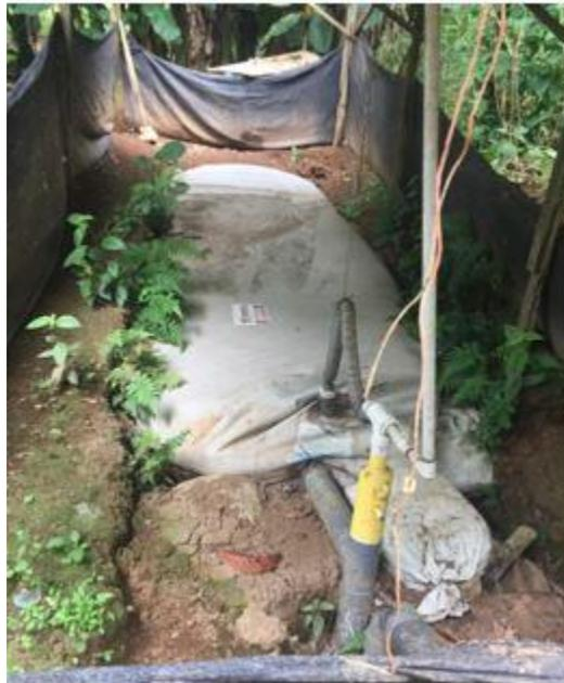
**Figura 5-4. Biodigestor con problemas de taponamiento en las tuberías de salida.**
