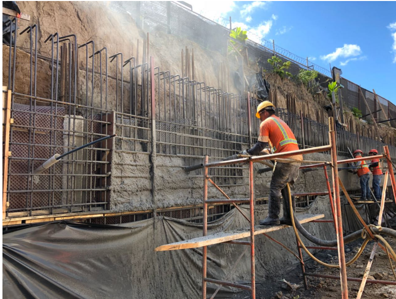
Figura 4.22: Construcción de Muro Anclado en proyecto Torre Este.
