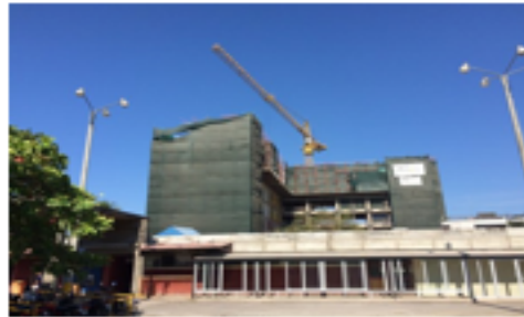
Encamados Provisionales Hospital de Puntarenas
