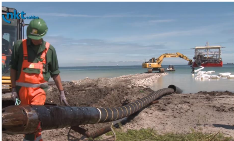
Figura 5.13. Colocación de cables de evacuación eléctrica de 245 kV a nivel costero. OWF Anholt, Dinamarca Fuente: Nordiske Kabel og Traadfabriker (NKT), (2013).
