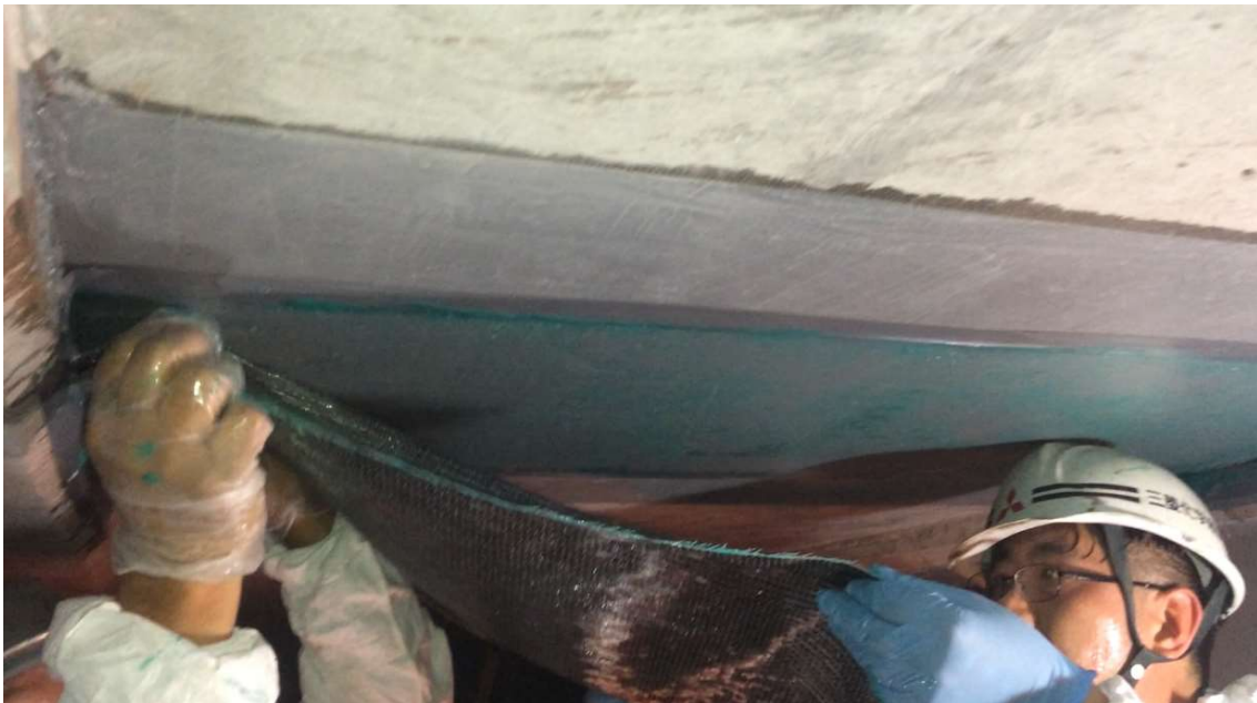
Colocación de la fibra de carbono por el técnico de Mitsubishi en Puente Sarapiquí (11 marzo 2015)
