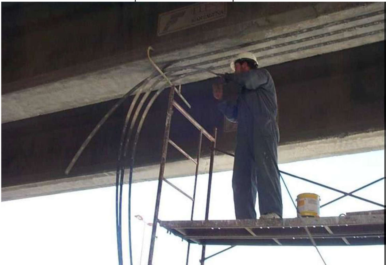
Figura 2.4. Instalación de platinas de CFRP (Fuente: Jorge Rendón, SYKA)
