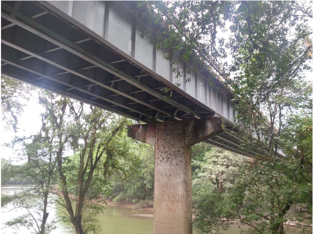
Vigas reparadas y pintadas post intervención.
