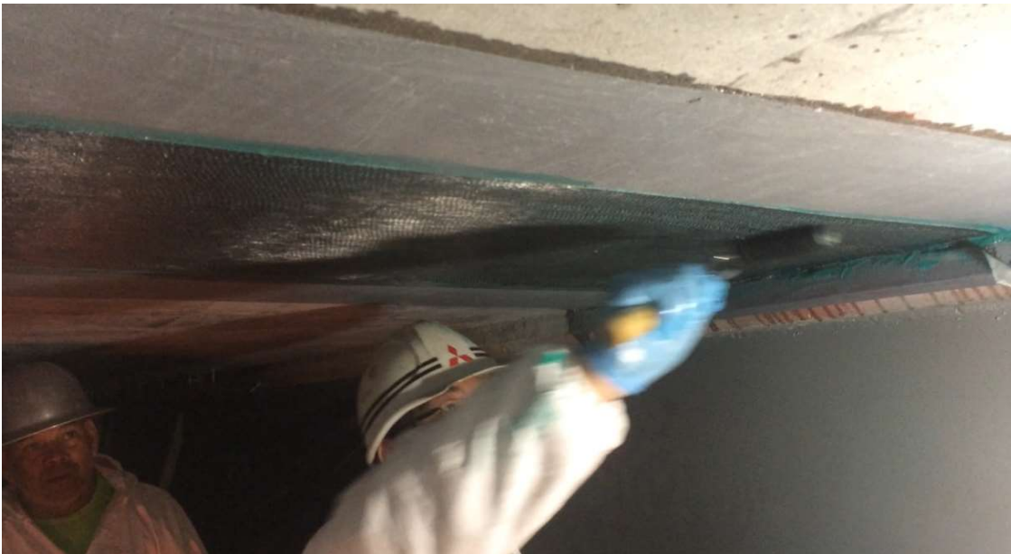
Impregnación de resina para segunda capa de fibra de carbono con rodillo (overcoating)
