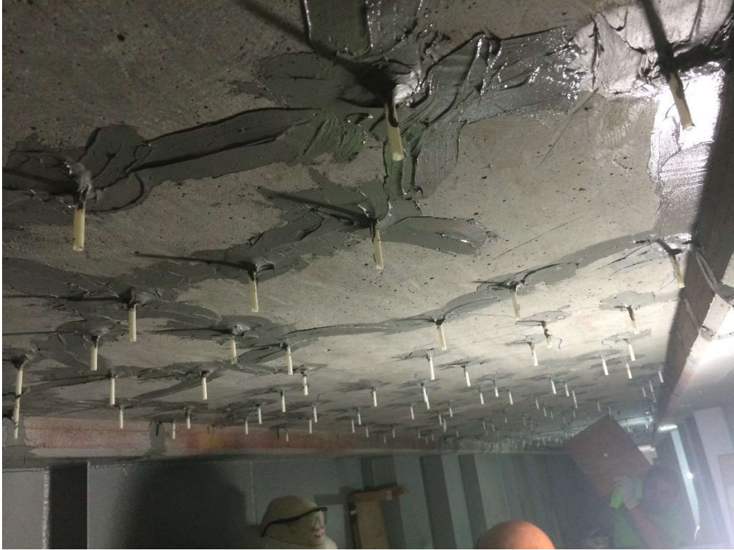
Inyección de grietas en la losa (marzo 2015)
