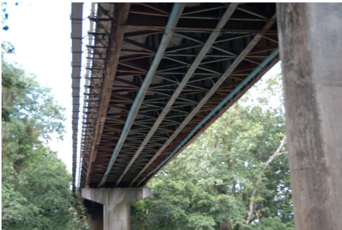
Vista inferior del puente sobre el Río Sarapiquí previo intervención
