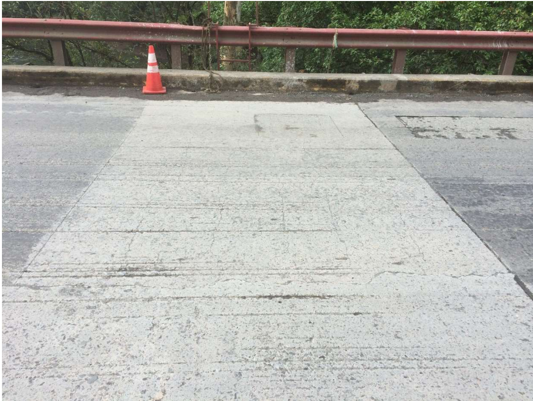
Preparación de losa superior para sellado de grietas (marzo 2015)
