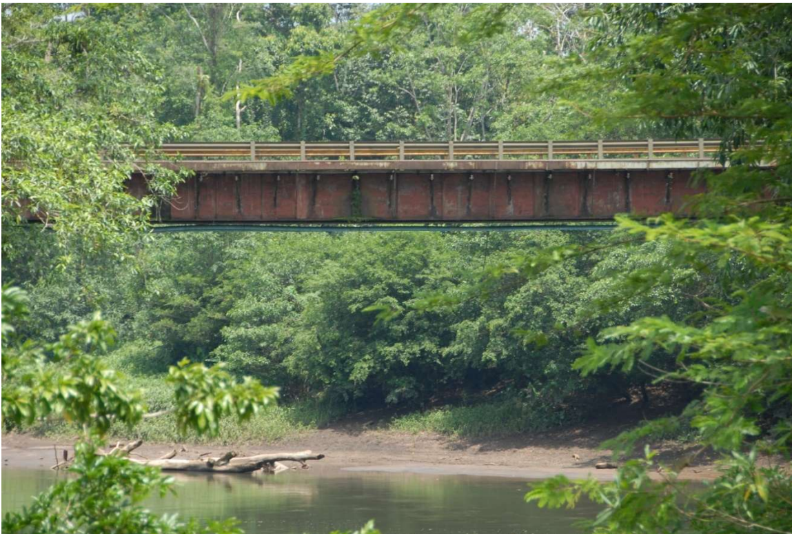
Vista lateral del puente sobre el Río Sarapiquí previo intervención
