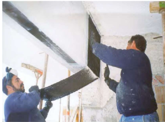
Figura 2.3. Instalación de CFRP curado en sitio (Fuente: Jorge Rendón, SYKA)
