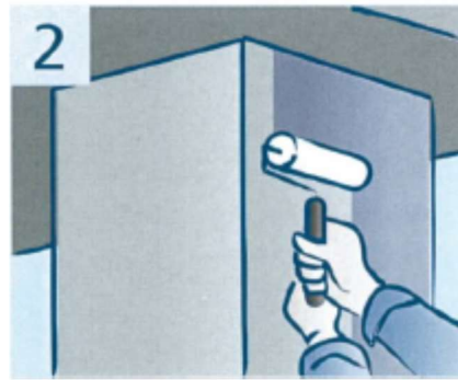
Aplicación de resina ("undercoating")
