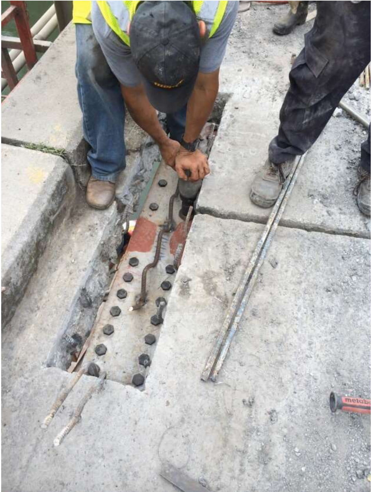
Modificación de viga tipo Gerber a elemento continuo en superestructura (Febrero 2015)
