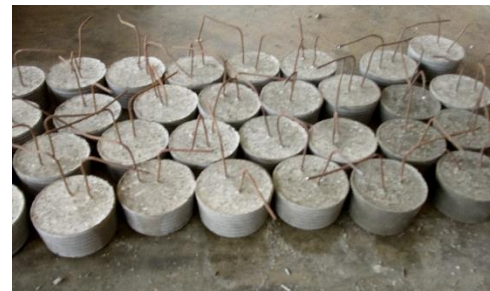
Figura 27: Separadores de concreto reforzado
