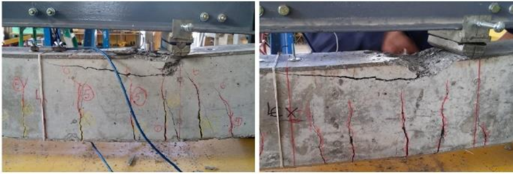
Figura 79: Área de falla en viga de concreto con material vítreo versus sin material vítreo
