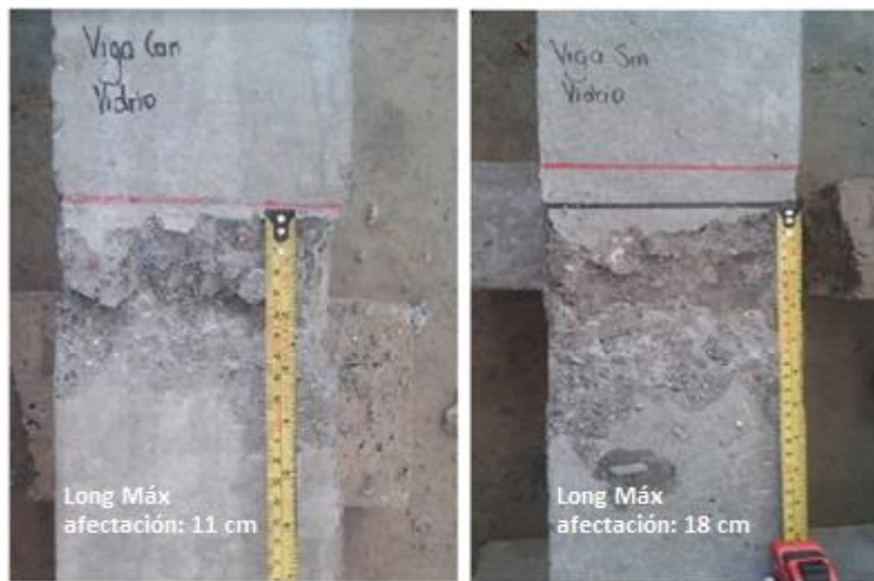
Figura 80: Área de afectación en falla en viga de concreto con material vítreo versus sin material vítreo
