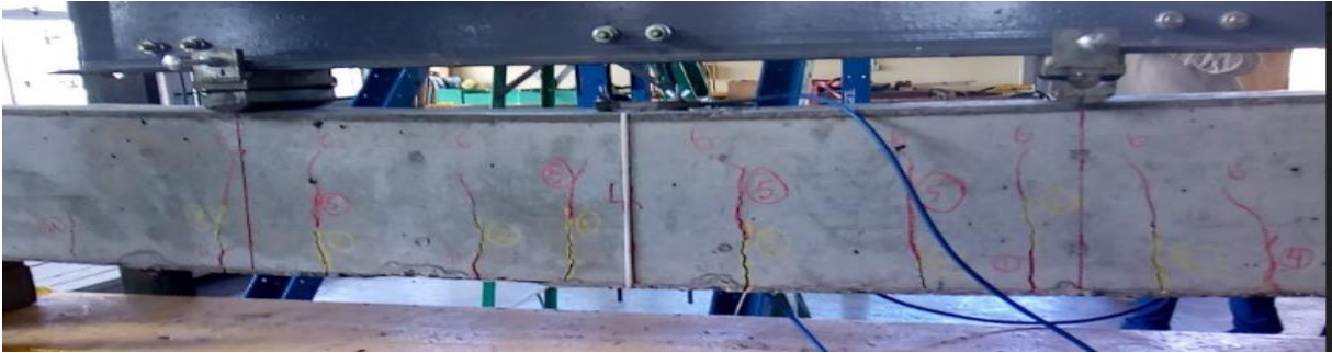
Figura 61: Desarrollo de grietas en vigas en estudio
