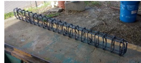
Figura 26: Armadura de viga.
