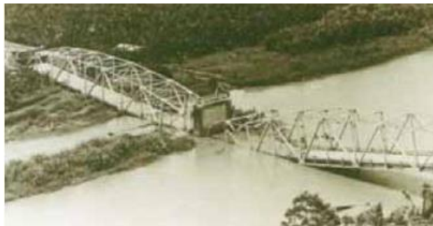
Figura 1. Colapso del Puente sobre el Río La Estrella.
