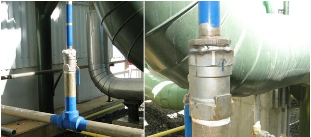
Figura II.3 Corrección de fuga en llave hacia válvulas de condensador
