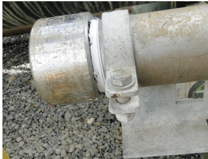
Figura 3.11 Fuga corregida con teflón en tapón
