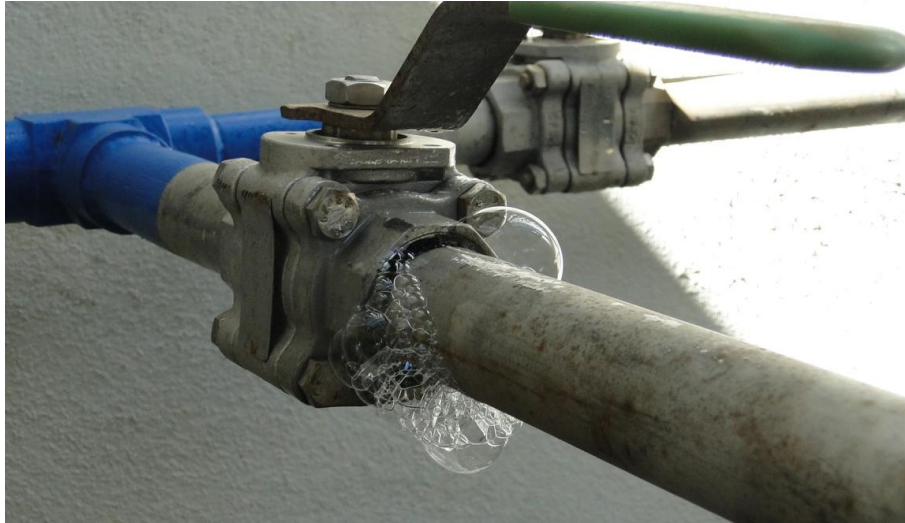
Figura 3.8 Fuga en llave que va hacia la válvula de flujo mínimo de pentano
