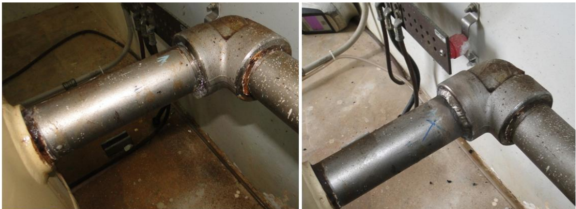
Figura II.1 Corrección de fuga en codo hacia tanque de almacenamiento
