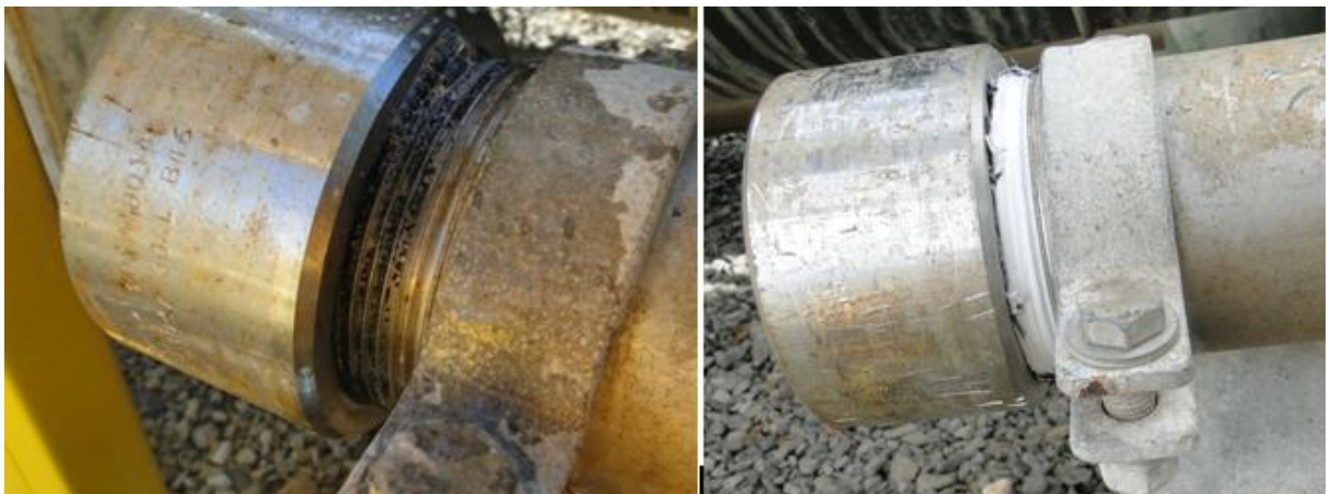
Figura II.4 Corrección de fuga en tapón de 3 pulgadas
