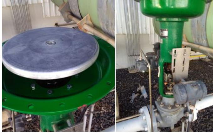
Figura 3.12 Trabajo de cambio de empaque en válvula de flujo mínimo
