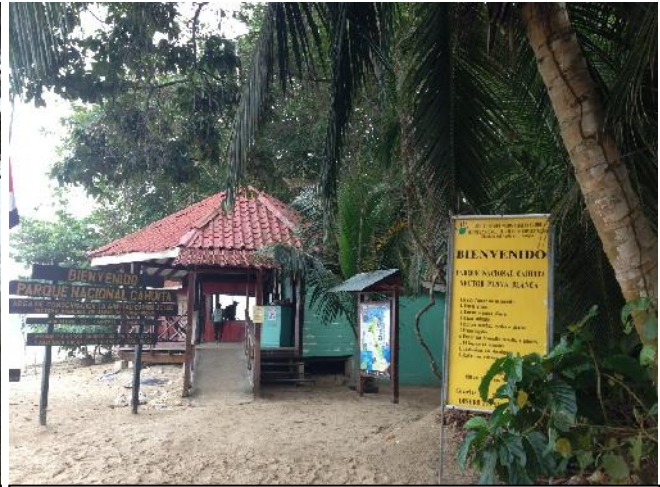
Foto 2. Infraestructura en la zona pública de la zona marítima terrestre
