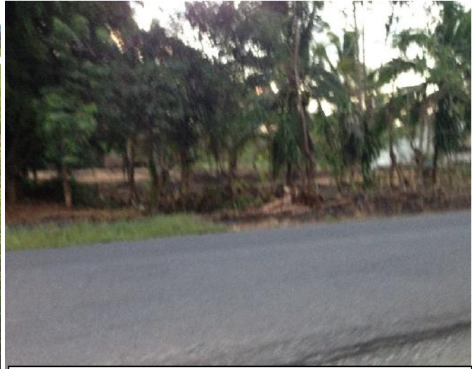
Foto 4. Carretera construida paralela a la costa ruta Limón Sixaola
