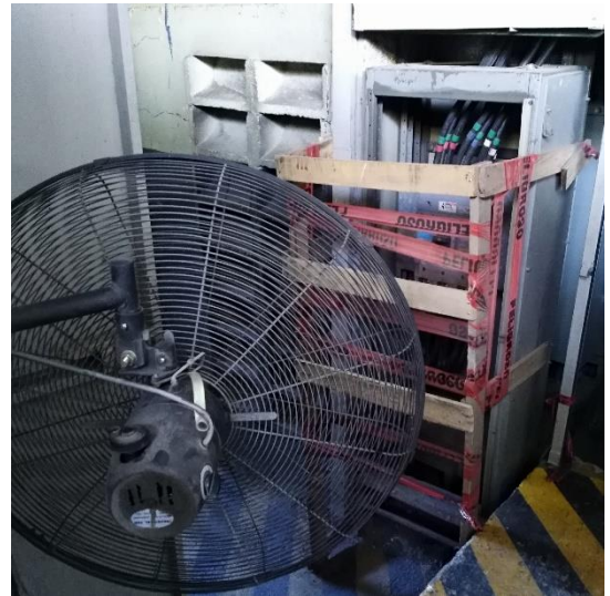
Figura 12. Medio de desconexión principal.
