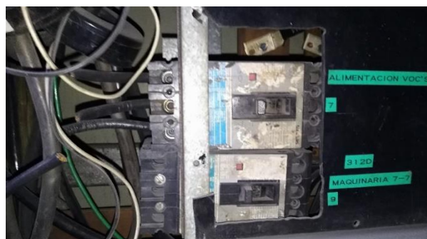
Figura 29. Interruptor sin uso en panel 122V.
