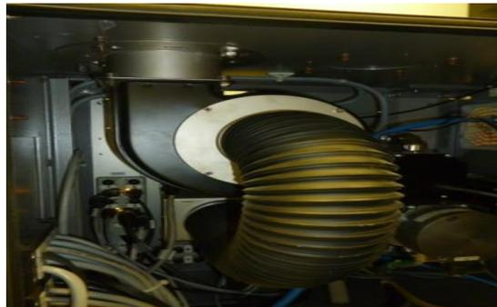
9.16.1. Inspeccionar ducto de aire caliente en busca de daños por calentamientos o fugas de aire.
