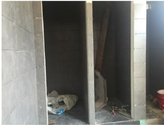
INSTALACION DE AZULEJOS EN BAÑOS
