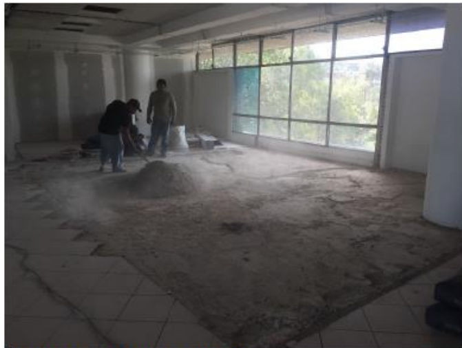
NIVELACION DE LOSA PARA PISO NUEVO
