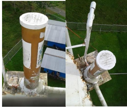
Fotografía 1. Equipo de cloración instalado en la ASADA de Agrimaga.
