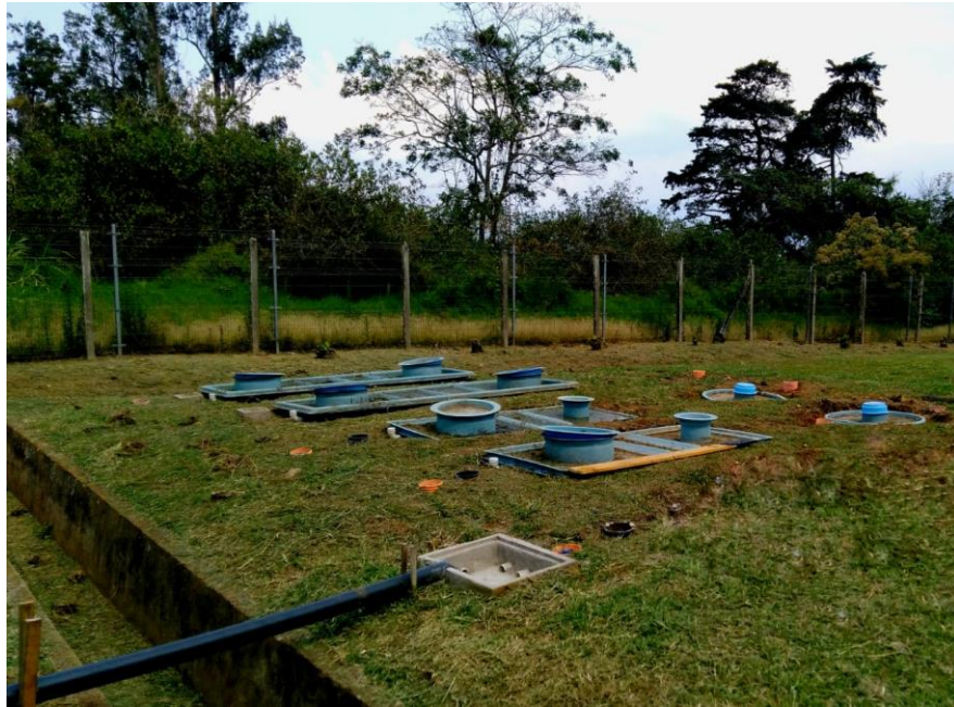
Figura 5.1. Instalación de la planta de tratamiento de tanques sépticos modificados
