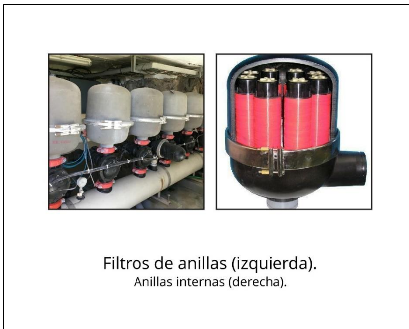
Figura 1.1. Sistema de filtración de agua instalado en una de las estaciones de filtrado propiedad de Papagayo Servicios Generales (izquierda). Tecnología interna del sistema de filtración (derecha) [8].
