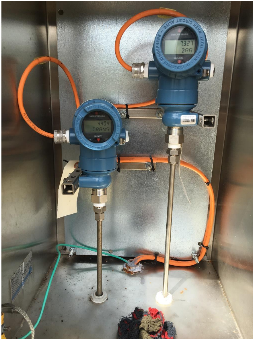
Figura 7. 2 Instrumentación instalada en los pozos de la plazoleta 1.
