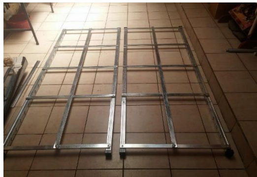
Figura 3.6 Armazón de hierro galvanizado empleando canal para gypsum.
