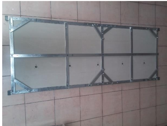
Figura 3.7 Láminas de plyrock acopladas a la armazón.
