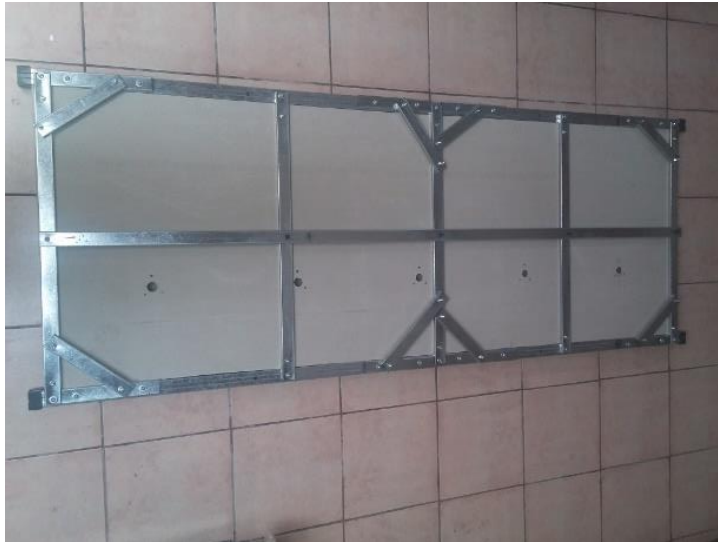
Figura 8. Láminas de plyrock acopladas a la armazón
