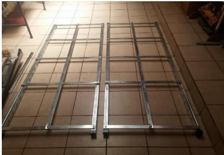
Figura 7. Armazón de hierro galvanizado empleando canal para gypsum
