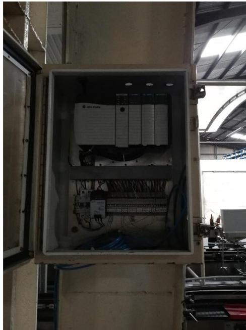
Figura 12. Ubicación De PLC Para El Horno 100
