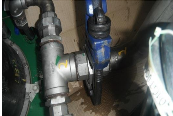
Figura 23. Montaje de tuberías
