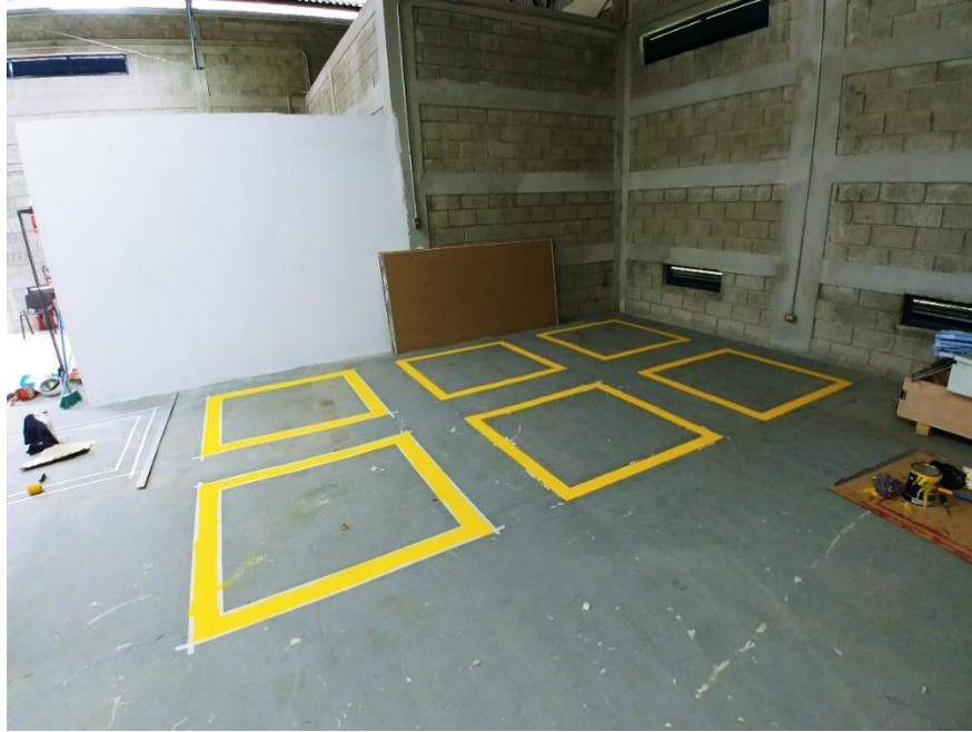
Figura 5.16. Demarcación de pisos Fuente: Elaboración propia
