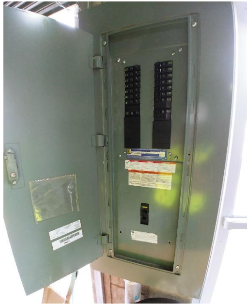
Figura 5.3. Centro de carga de bodega general Fuente: Elaboración propia
