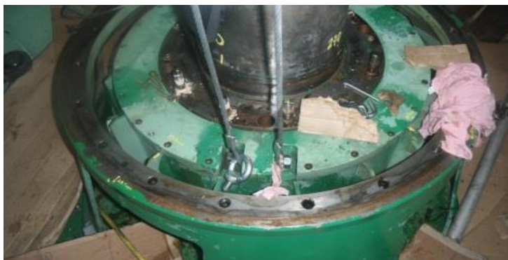
Figura 11. Extracción de tapa de cuba
