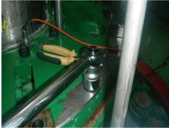
Figura 22. Torque de tapa principal
