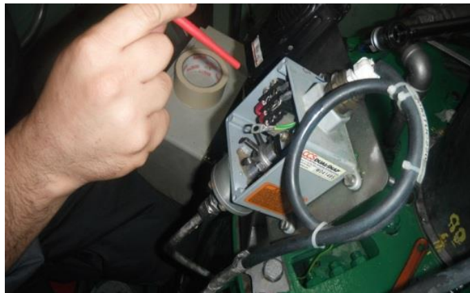
Figura 24. Montaje de instrumentación
