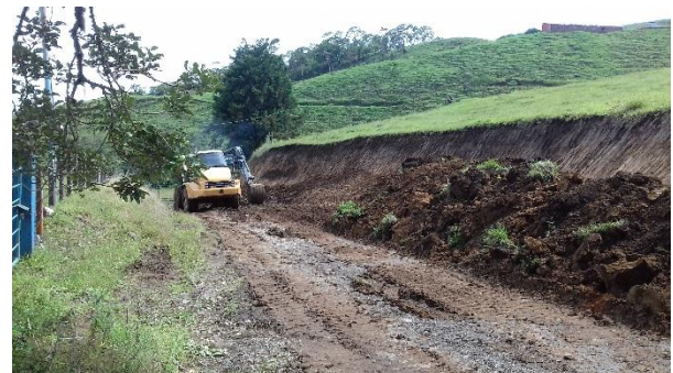
Figura 4. Excavación de la vía.
