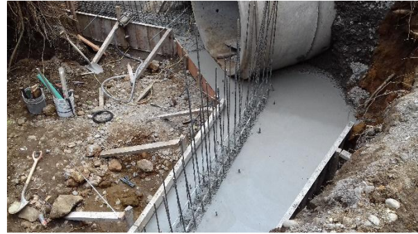
Figura 11. Elaboración de cabezales y placas de alcantarilla.
