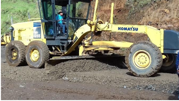
Figura 9. Colocación de subbase en la vía.
