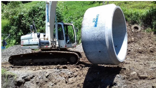
Figura 6. Instalación de tubería.
