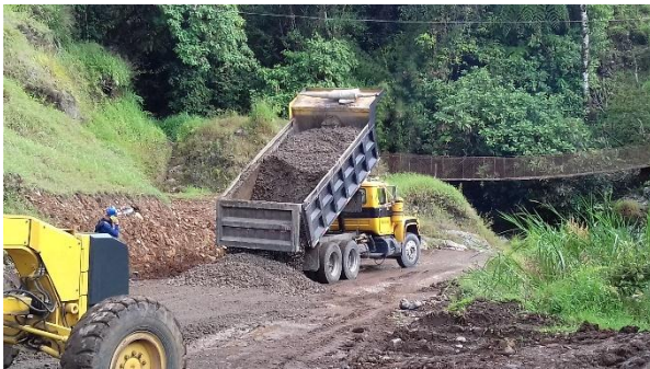
Figura 10. Colocación de base de agregados.
