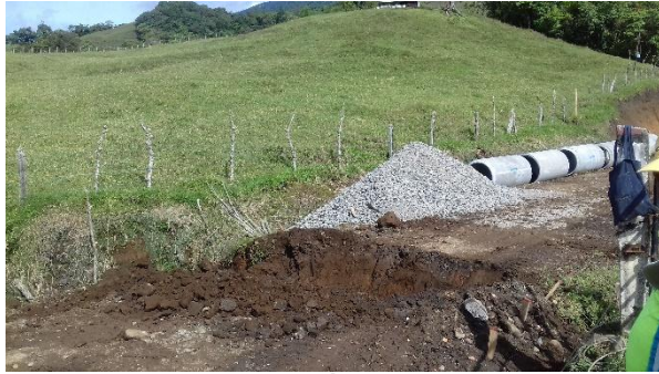
Figura 5. Excavación para estructuras.
