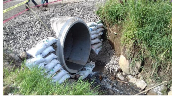
Figura 7. Relleno para alcantarillas.
