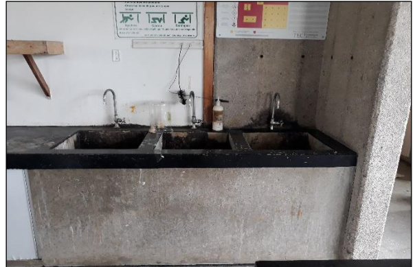
Fotografía 19. Pila del muro E
