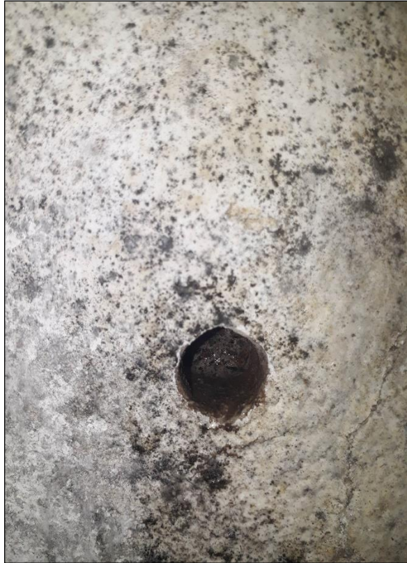
Fotografía 38. Prueba de fenolftaleína muro C sección 1
