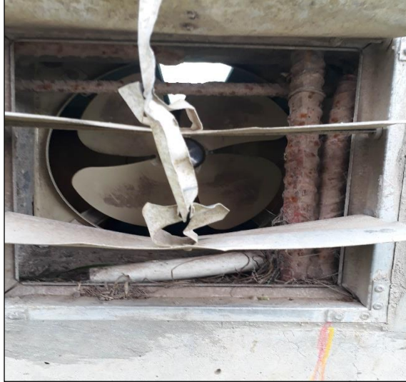
Fotografía 5. Varilla expuesta con evidente corrosión
