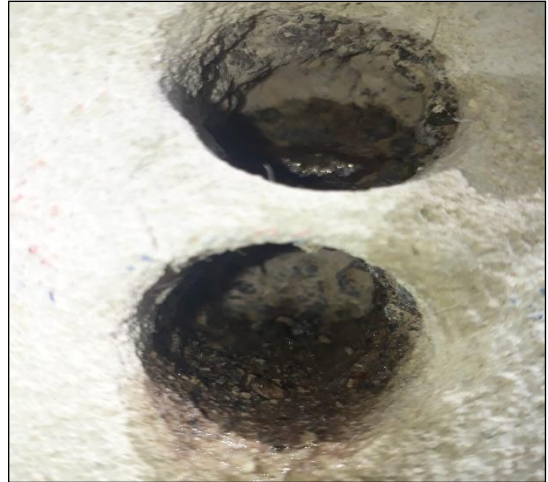
Fotografía 40. Prueba de fenolftaleína muro D
