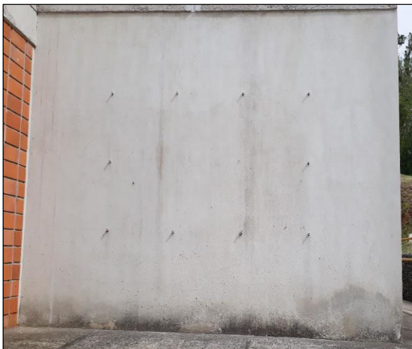
Fotografía 12. Muro D ala oeste CIBITEC
