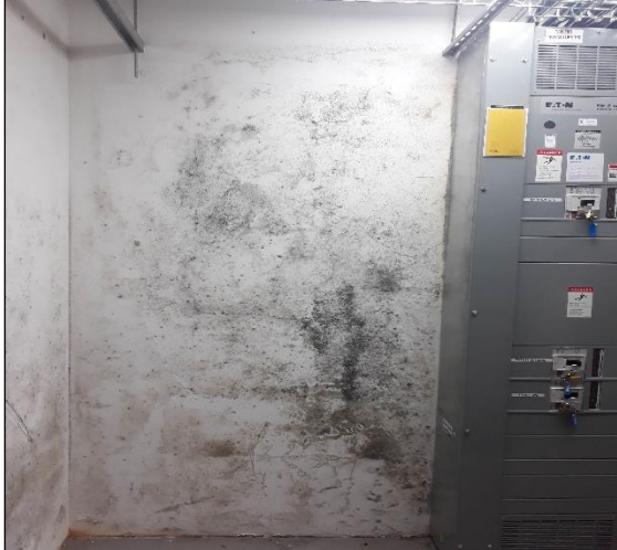
Fotografía 10. Muro C sección 1
