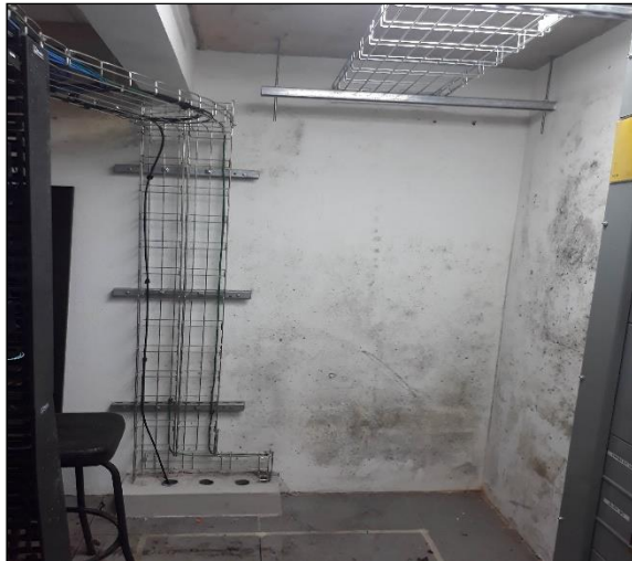
Fotografía 11. Muro C sección 2
