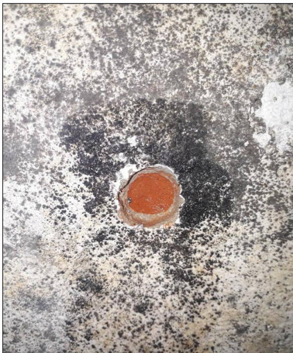
Fotografía 39. Prueba de fenolftaleína muro C sección 2
