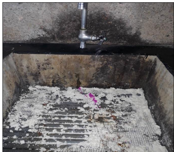
Fotografía 21. Estado actual de las pilas
