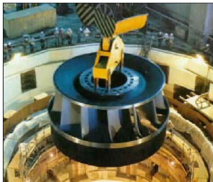
Figura 3.6 Rodete de una turbina Francis [21].
