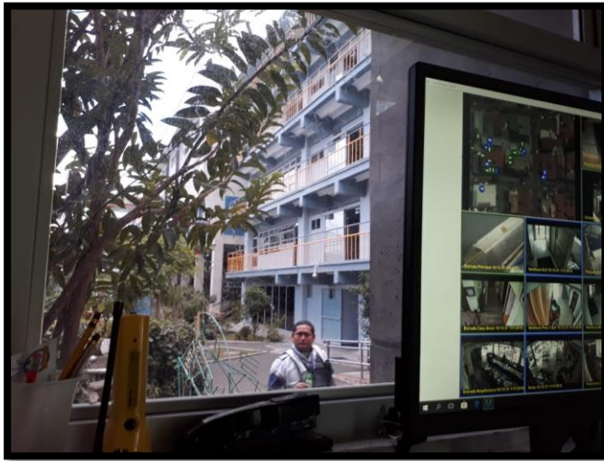
Figura 26: Instalación Seguridad y Vigilancia
