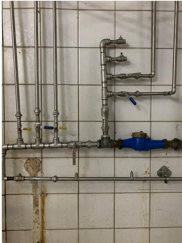
Figura 2. Sistema de suministro hídrico actual.
