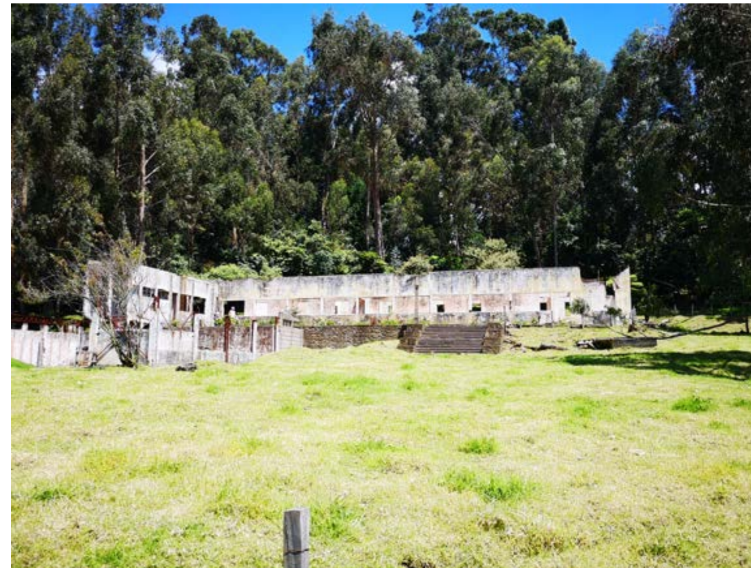
Imagen 03 - Antiguo pabellón de hombres del Sanatorio Durán.
