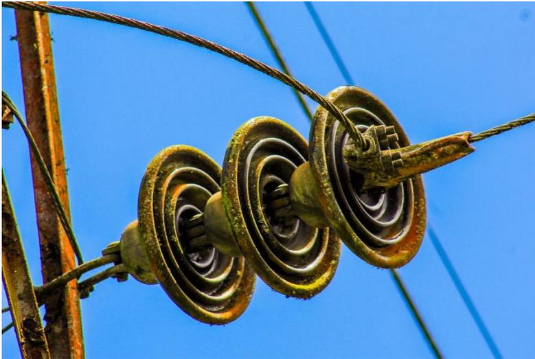
La importancia de los aisladores está en la necesidad de brindar continuidad operacional en las líneas y mantener aisladas las partes energizadas. Si un aislador se encuentra sucio o roto, este afectará el rendimiento de la línea, y producirá más salidas por interrupciones.
