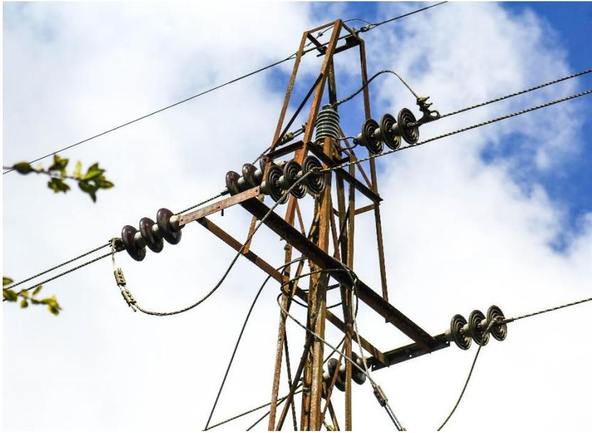
En muchos de los postes metálicos del ramal, los *jumpers* se encuentran muy cerca de la estructura metálica, o están muy flojos, haciendo que las posibilidades de que golpee el metal son muy altas, o de que un pájaro haga conexión a tierra cuando toque el cable y la estructura.
