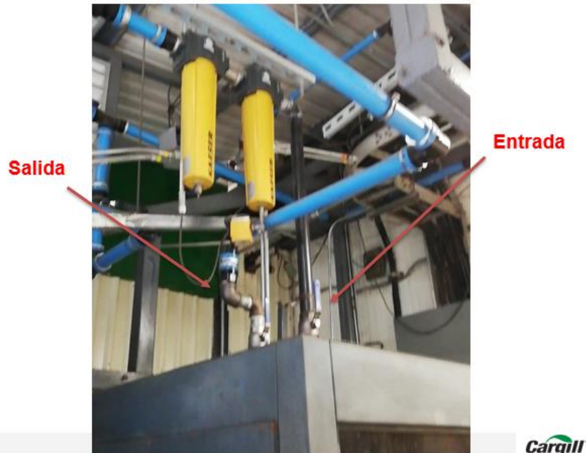
Figura 41. Conexión del secador de aire indicando la correcta disposición de tuberías.
