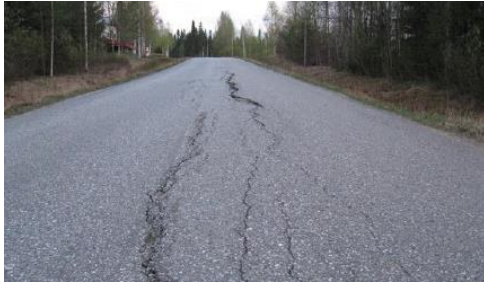
Figura 72. Ejemplo hinchamiento Fuente: Ministerio de Obras Públicas y Transportes, 2011
