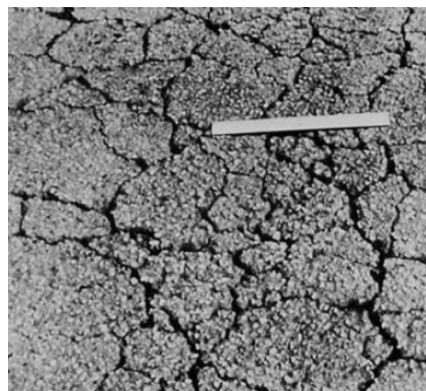
Figura 14. Cuero de lagarto – severidad alta Fuente: Norma ASTM D6433-18, 2018
