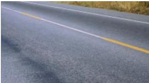
Figura 15. Exudación – severidad baja Fuente: Ministerio de Obras Públicas y Transportes, 2011
