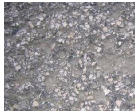
Figura 55. Pulimientto de agregados Fuente: Ministerio de Obras Públicas y Transportes, 2011
