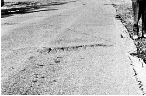
Figura 24. Abultamientos y hundimientos – severidad media Fuente: Norma ASTM D6433-18, 2018
