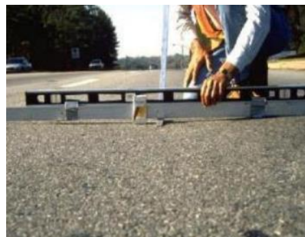
Figura 64. Rodera – severidad baja Fuente: Ministerio de Obras Públicas y Transportes, 2011
