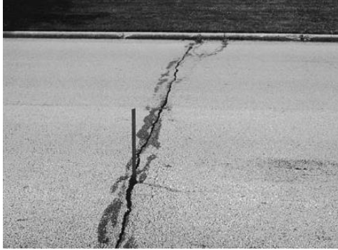
Figura 49. grieta longitudinal – transversal severidad media
