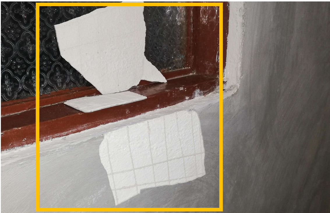
Figura 4. Desprendimiento de repello en pared con una semana de colocado aproximadamente. Fuente. Fotografía propia, 2019.
