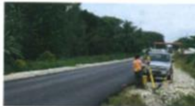
Figura 2. Trabajos de topografía en la zona a intervenir
