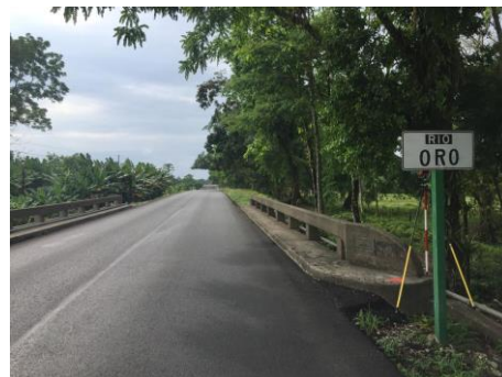
Figura 6. Revisión del levantamiento topográfico
