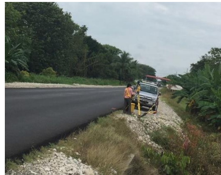
Figura 5. Revisión del levantamiento topográfico
