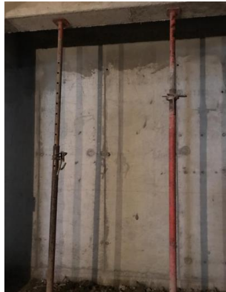
Imagen 13. Reparación en muro utilizando mortero expansivo Maxibed
