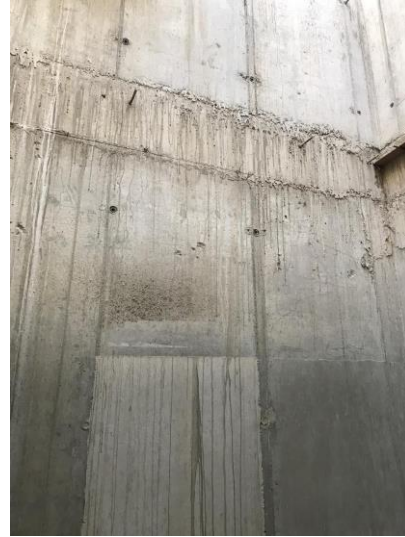
Imagen 10. Limpieza de muros Fuente. Elaboración propia
