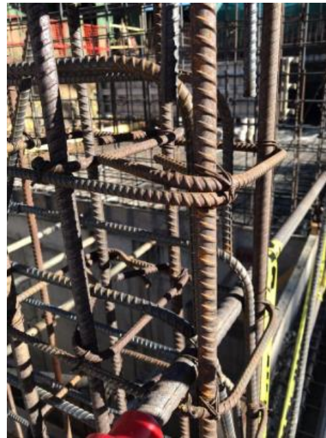
Imagen 14. Cuantía de acero en columna
